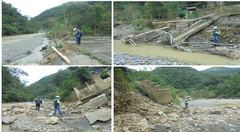
FOTO N° 01, 02, 03, 04: Muestran el colapso de la plataforma deportiva en la margen izquierda, por desborde del rio Tambopata.
